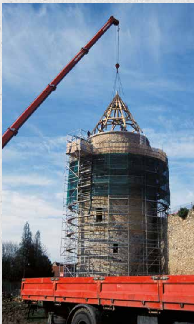
Travaux de remontage de la toiture sur la tour des gardes (1994). Photo Jacques Moulin.
