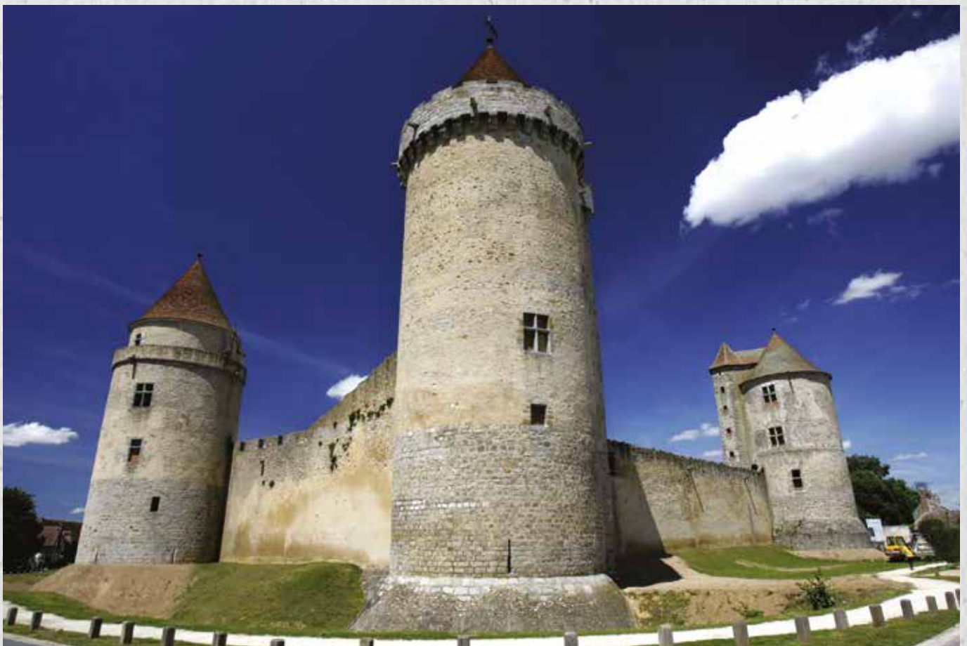
Vue de la tour des gardes, du donjon et de la tour des archives (de gauche à droite) © Département de Seine-et-Marne, Patrick Loison.
